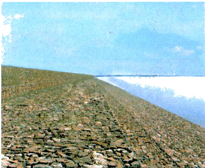
Рис. 40. Крепление затапливаемого берега габионами матрацно-тюфячной конструкции. Фото Б. В. Бабикова
